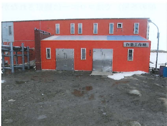
写真19 作業工作棟 全体
