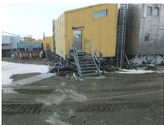
写真21 防火区画Cの外側 全体
