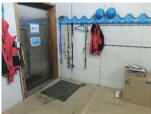
写真13 防火区画Cの内側 全体
