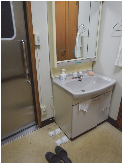
写真4 管理棟洗面所
