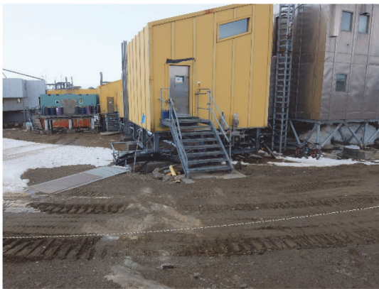
写真21 防火区画Cの外側 全体
