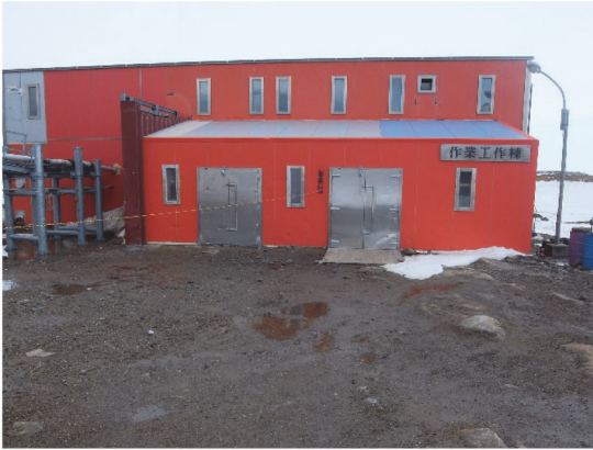
写真19 作業工作棟 全体
