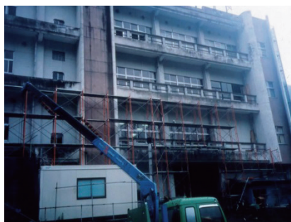
壁面工事がはじまった天龍村役場庁舎
