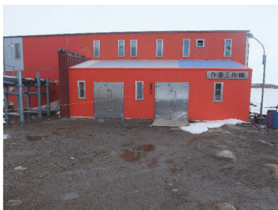
写真19 作業工作棟 全体
