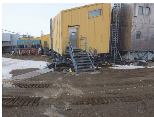
写真21 防火区画Cの外側 全体
