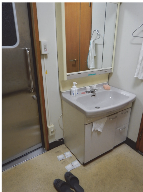
写真4 管理棟洗面所
