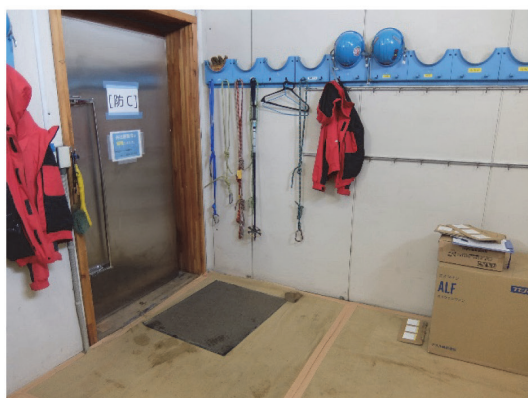
写真13 防火区画Cの内側 全体
